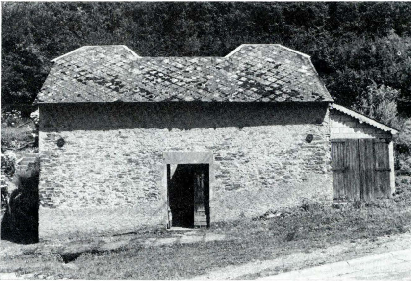
Pussemange. — Lavoir présentant une grande ouverture rectangulaire au centre de sa toiture.
