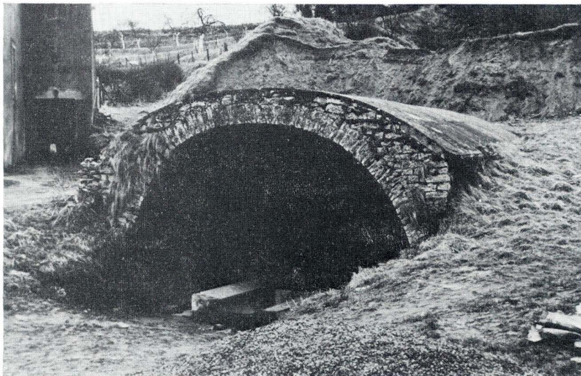
Saint-Léger. — Un des deux lavoirs-tunnels.
